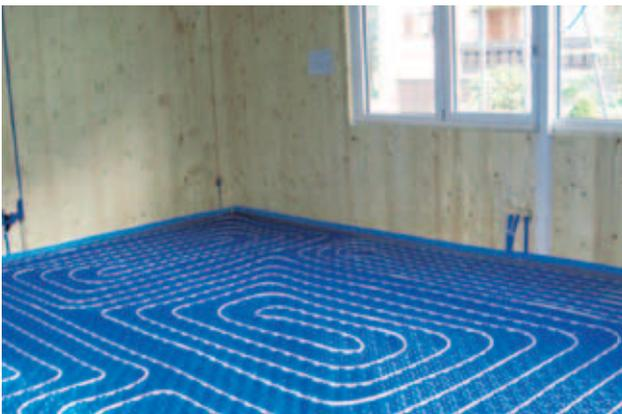
Fig. 15: Sistema de tuberías de una calefacción por suelo [por gentileza de Eberle • d e n k f a b r i k •, Dornbirn, Austria]
