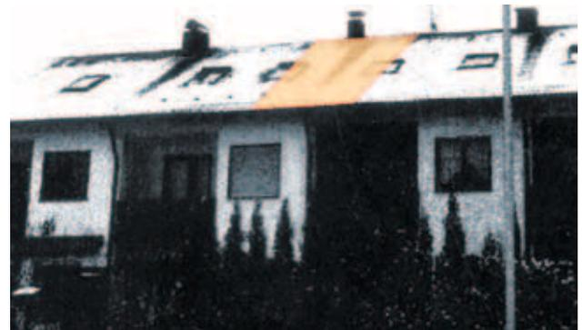
Fig. 5: A lo largo de un puente térmico de un metro lineal situado en la parte superior de una construcción de mampostería, se pierde la misma cantidad de calor que en tres metros cuadrados de tejado no interrumpido. Los puntos débiles en la zona del tejado se aprecian fácilmente (como muestra la figura) en la capa de nieve fundida
