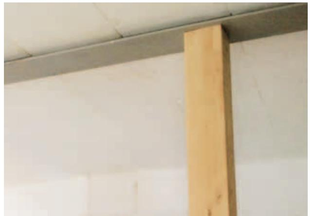
Fig. 6: Aparición de un puente térmico lineal. Si el soporte de acero no va a ser integrado en el aislamiento, lo más probable es que se produzcan daños por condensación
