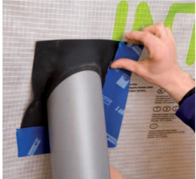
Fig. 11: En caso de que no se puedan evitar las perforaciones, deberán utilizarse sistemas de estanqueidad adecuados y de eficacia probada. Un montaje estanco rápido y duradero justifica los gastos adicionales [por gentileza de la empresa Pro clima 2011]
