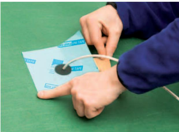
Fig. 10: En caso de que no se puedan evitar las perforaciones, deberán utilizarse sistemas de estanqueidad adecuados y de eficacia probada. Un montaje estanco rápido y duradero compensa los gastos adicionales [por gentileza de la empresa Pro clima 2011]
