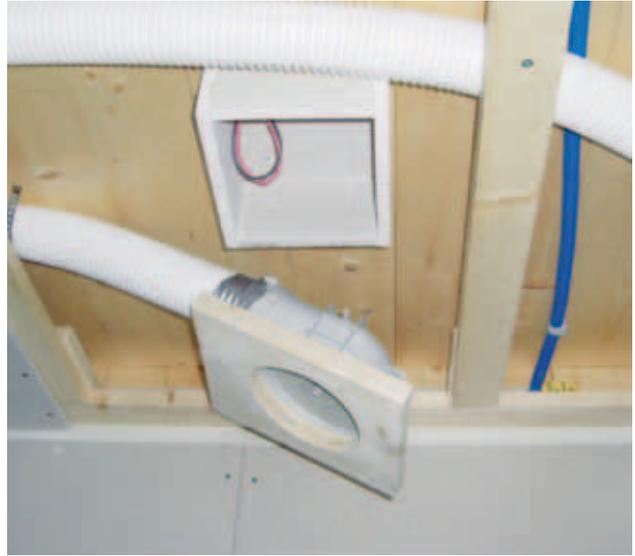
Fig. 14: Colocación de las tuberías detrás de un falso techo. Sistema HOVAL [por gentileza de Eberle • d e n k f a b r i k •, Dornbirn, Austria]
