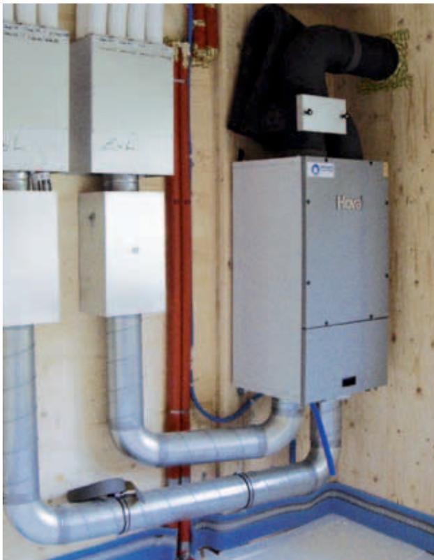
Fig. 13: Montaje de un equipo de ventilación en una pared KLH® [por gentileza de Eberle • d e n k f a b r i k •, Dornbirn, Austria]
